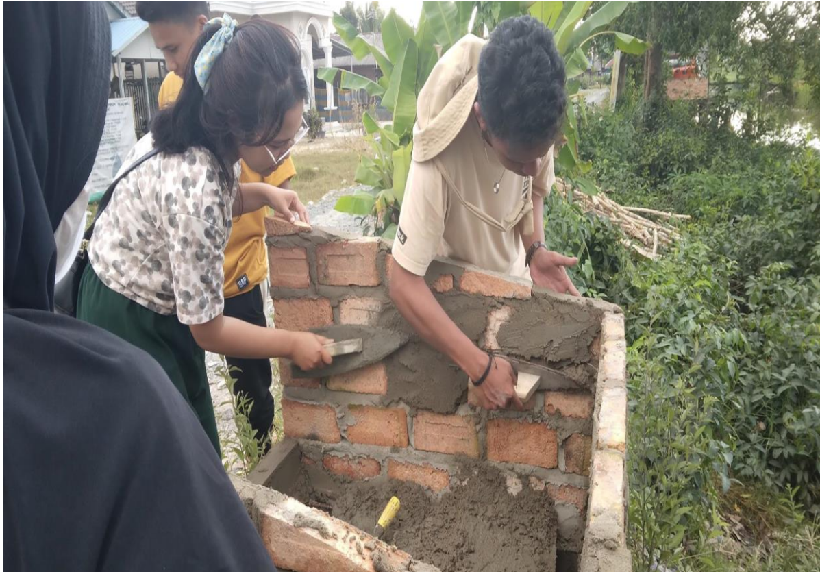
Gambar 2. Pembuatan TPS (Sumber: Dokumentasi tim pengabdian, 2023)
